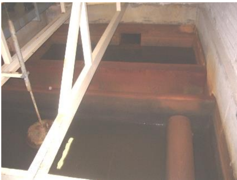
Рис. 7 Песчаный фильтр. Высота загрузки 0,8 м
